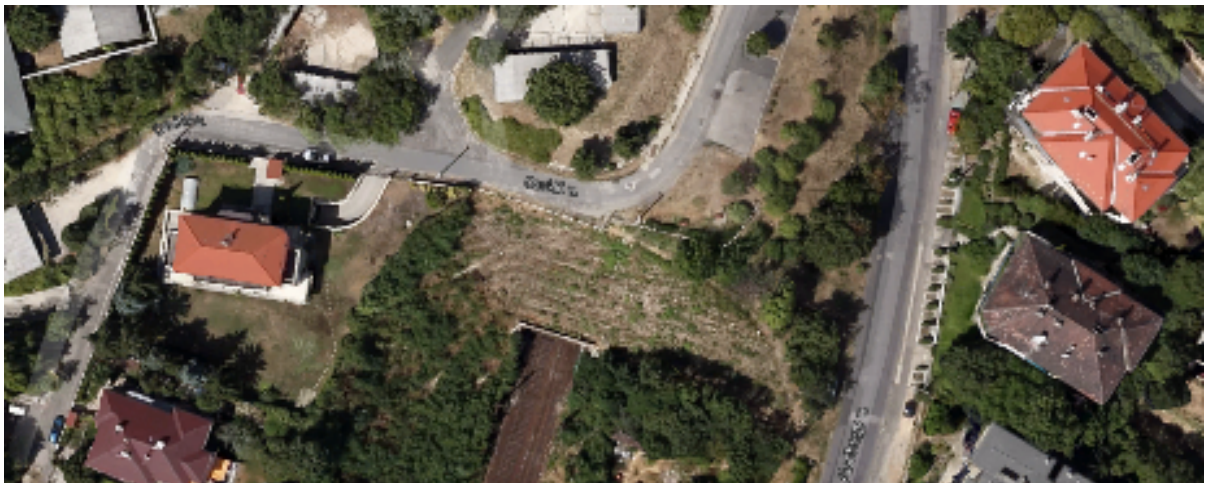
27. kép: A rézsűcsúszás környezete 2014-ben
