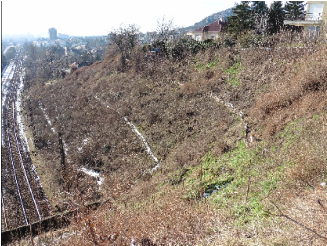
16. kép: Alacsony növényzetű, szivárgó rendszerrel ellátott részsűk
